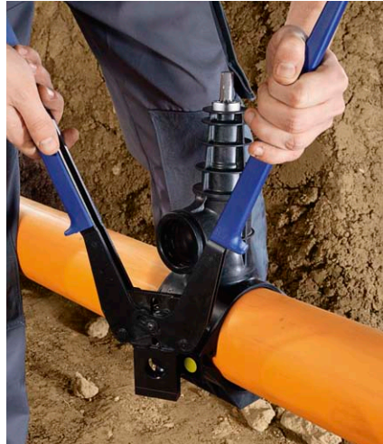
Armatur mit Handwerkzeug oder Pressgun verpressen.
