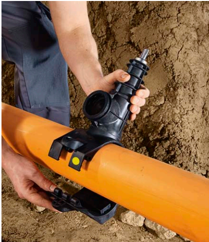
Anbohrarmatur aufsetzen.
