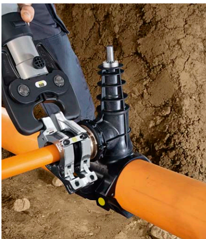
Hausanschlussleitung verlegen, verpressen und anschließend Druckprobe durchführen.
