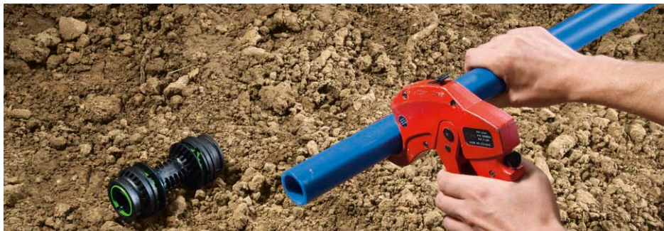
1. Rohr ablängen.
