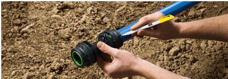
2. Verbinder aufstecken und Einstecktiefe mithilfe des Sichtfensters kontrollieren und markieren.
