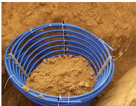
Erdwärmekörbe fördern die Wärme der oberen Erdschicht.
